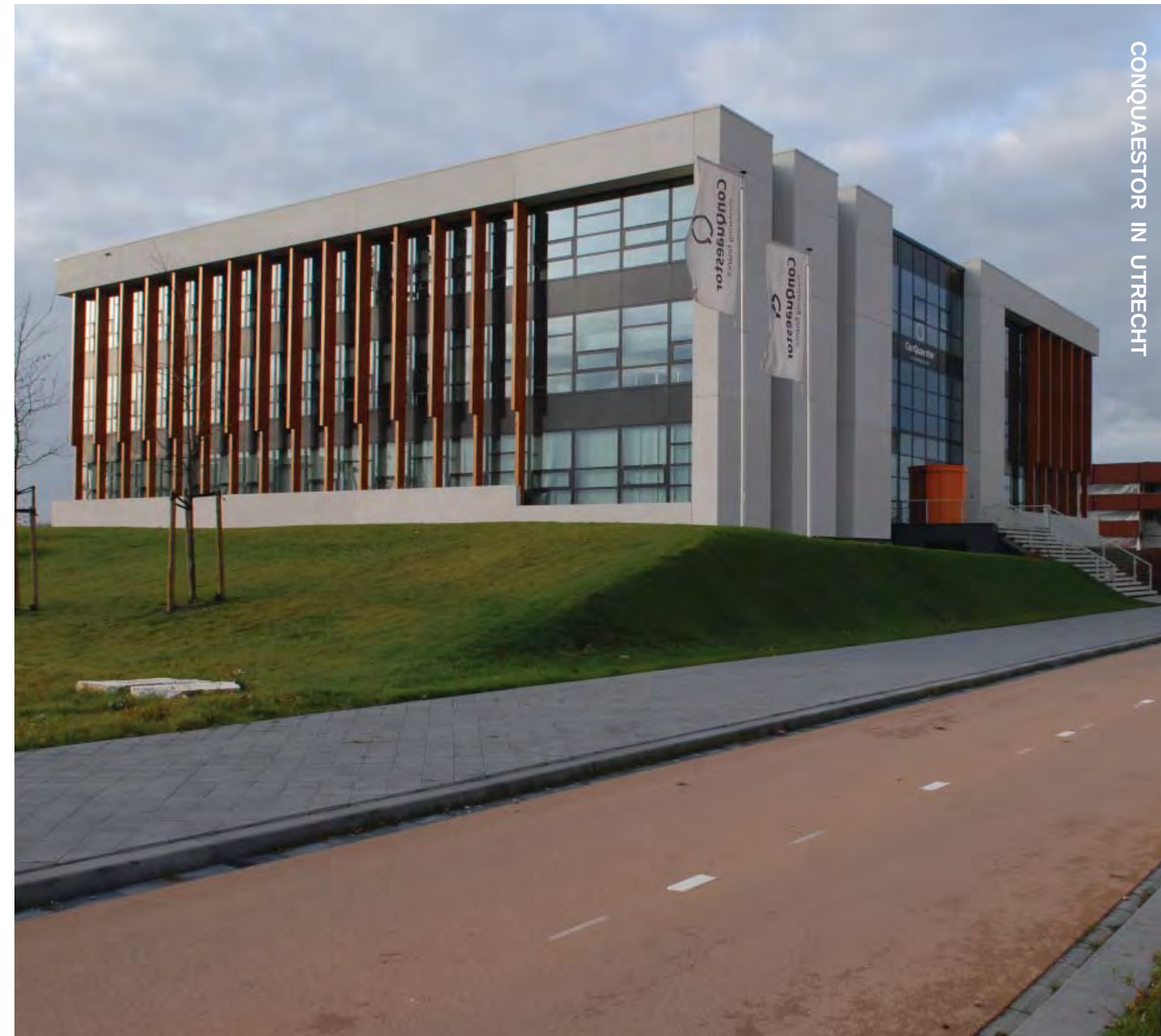
De doorgaande omvouwende structuur, bestaande uit witte prefabbeton elementen, vormt het gebouw. De gelamineerde houten kolommen, met terugliggende glasvlakken, geven het gebouw diepte.
