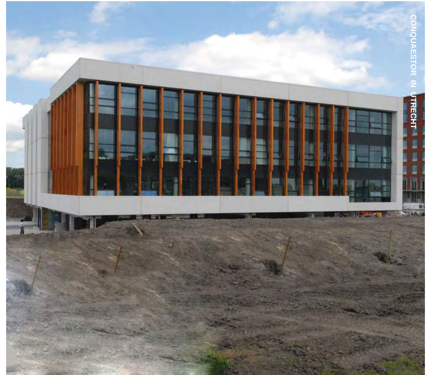
De parkeervoorziening ligt verdekt achter het glooiende terrein en onder het gebouw. De houten lamellen geven het gebouw ritme.
